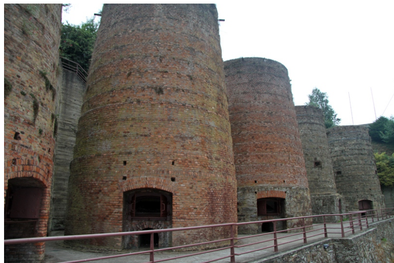
Fornos de calcinación de mineral de ferro en Vilaoudriz (A Pontenova). O primeiro forno levantouse en 1902 e chegou a haber ata cinco. Miden 11 metros de altura.
